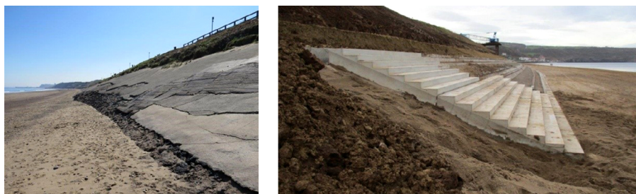
Fot. 6. Betonowa, schodkowa opaska brzegu, Sandsend, Whitby North Yorkshire, Anglia
