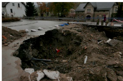
Fot. 1. Rozmycie prawego przyczółka oraz wyboje przed mostem na ul. Kościuszki na prawej terasie
