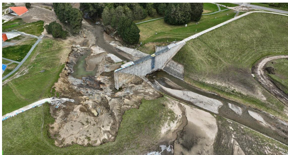
Rys. 2. Zbliżenie na korpus zapory – model mesh stanu po katastrofie (fotogrametria BSP)
