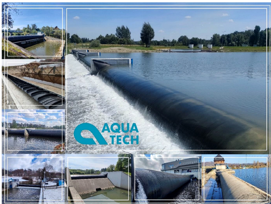
Rys. 1. Przykładowe realizacje autonomicznych jazów powłokowych
