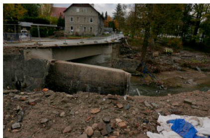
Fot. 1. Rozmycie prawego przyczółka oraz wyboje przed mostem na ul. Kościuszki na prawej terasie
