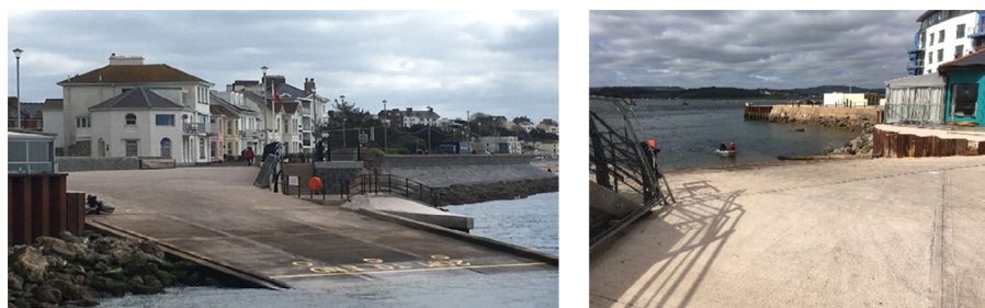
Fot. 4. Rampa zjazdowa do morza Exmouth, Devon, Anglia
