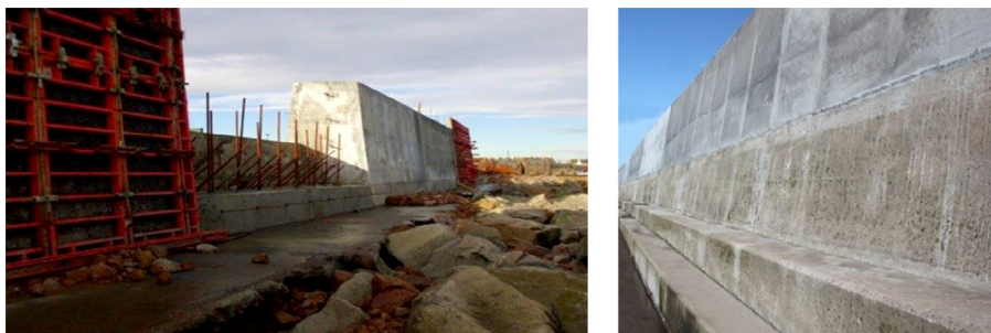
Fot. 3. Morski mur przeciwpowodziowy w Aberdeenshire, Anglia
