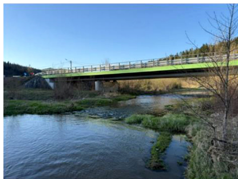
Fot. 1a) Obiekt mostowy w analizowanym odcinku Krzyworzeki, z widocznym odkładającym się poniżej rumoszem, b) zniszczony stopień betonowy poniżej mostu
